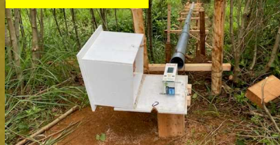
伸縮計設置状況
