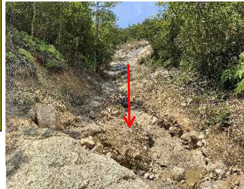
土砂流出状況
