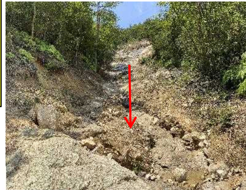
土砂流出状況
