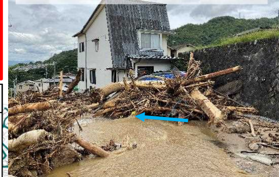
被害状況：太田川水系西山本川(その1)
