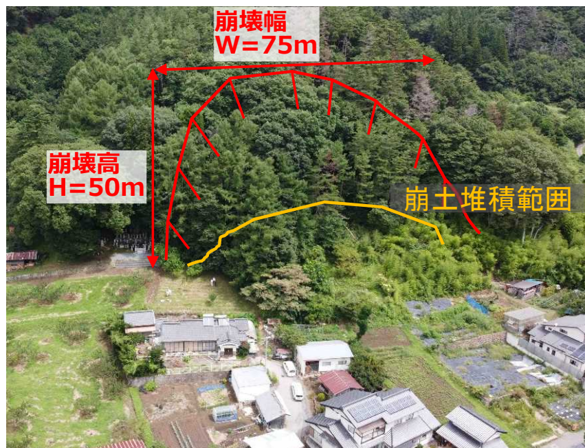
人家被害状況
