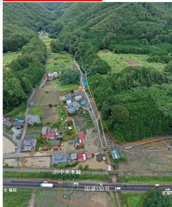
全景(氾濫状況)
