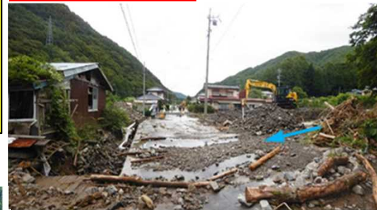
土砂流出状況
