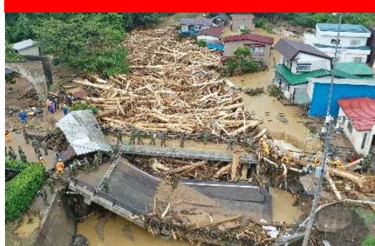
流木河道閉塞状況（小赤川橋）
