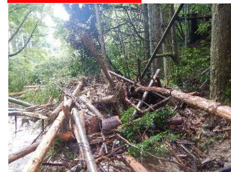
流木堆積状況
