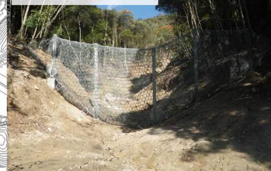
ワイヤーネット設置状況
