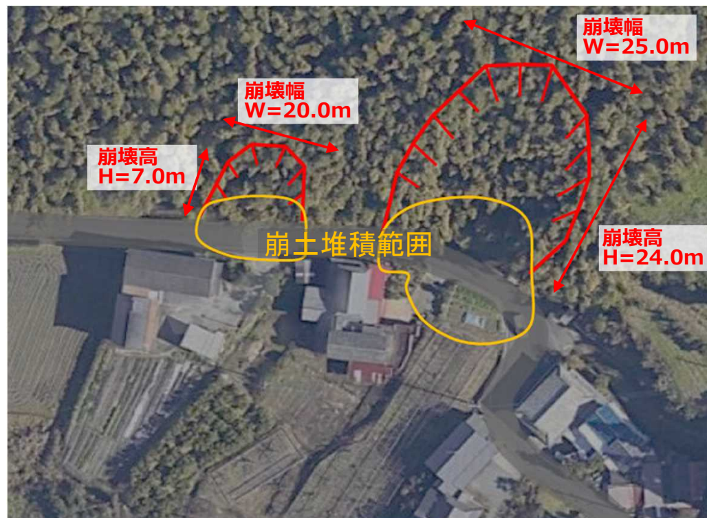
がけ崩れ状況 (がけ上側)
