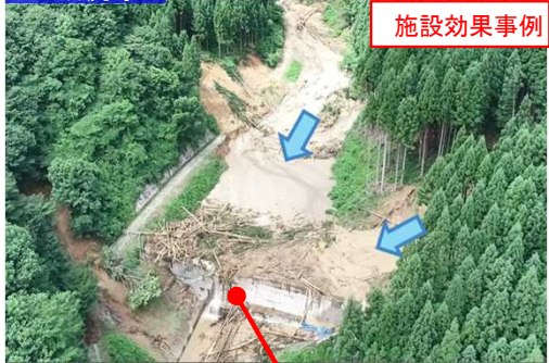
砂防えん堤が土石流を捕捉
