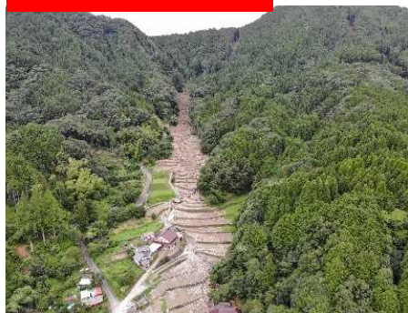
土砂流出状況
