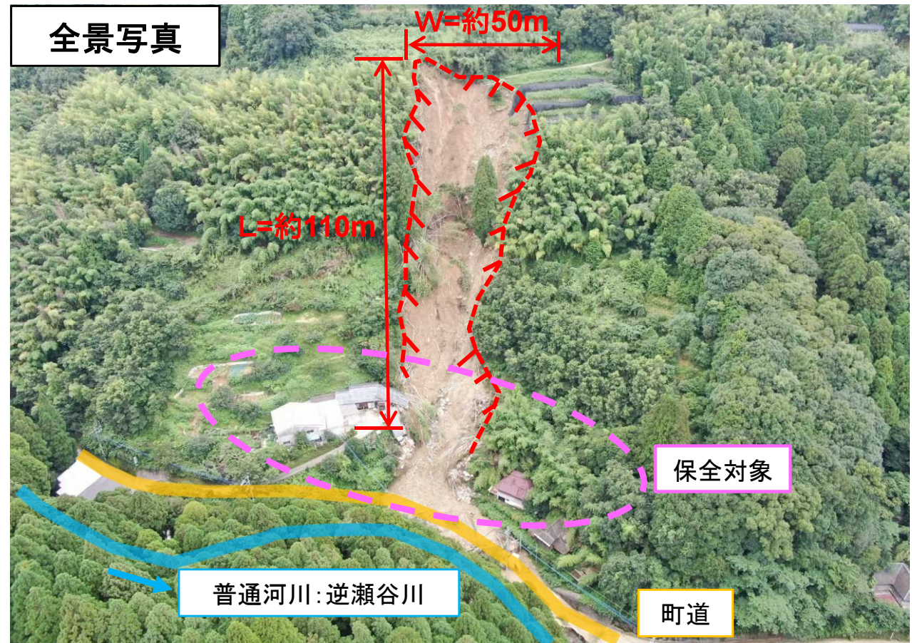
町道・河川の被災状況
