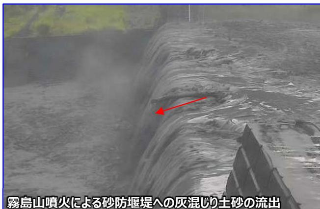
霧島山噴火による砂防堰堤への灰混じり土砂の流出
