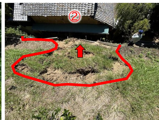
斜面の崩壊状況(頭部から崖下を望む)
