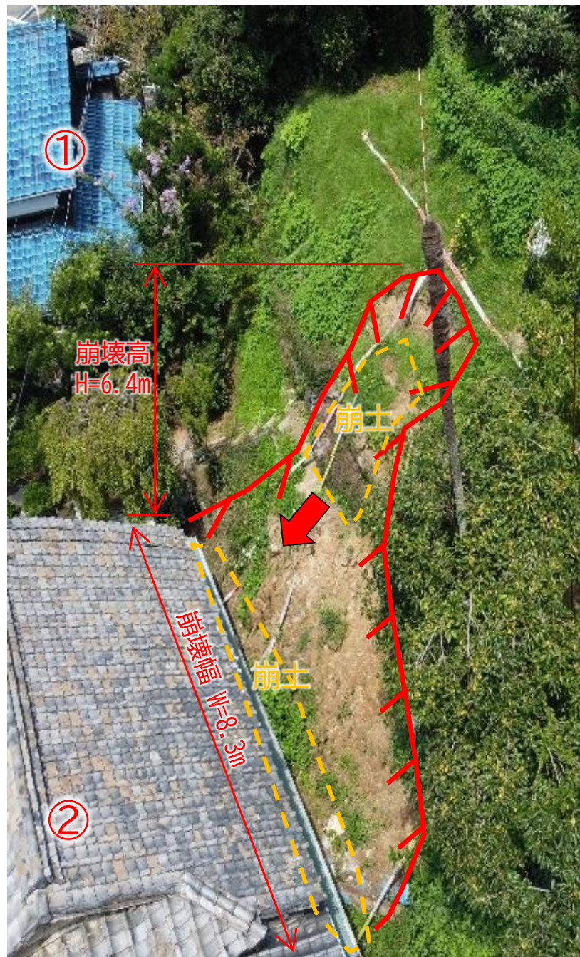
斜面の崩壊状況(頭部から崖下を望む)
