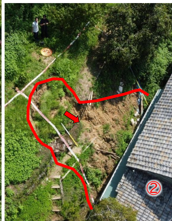
斜面の崩壊状況(全景)
