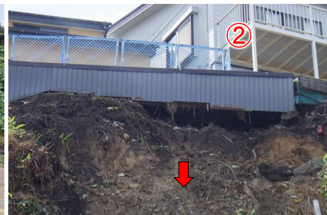
斜面の崩壊状況(滑落崖)
