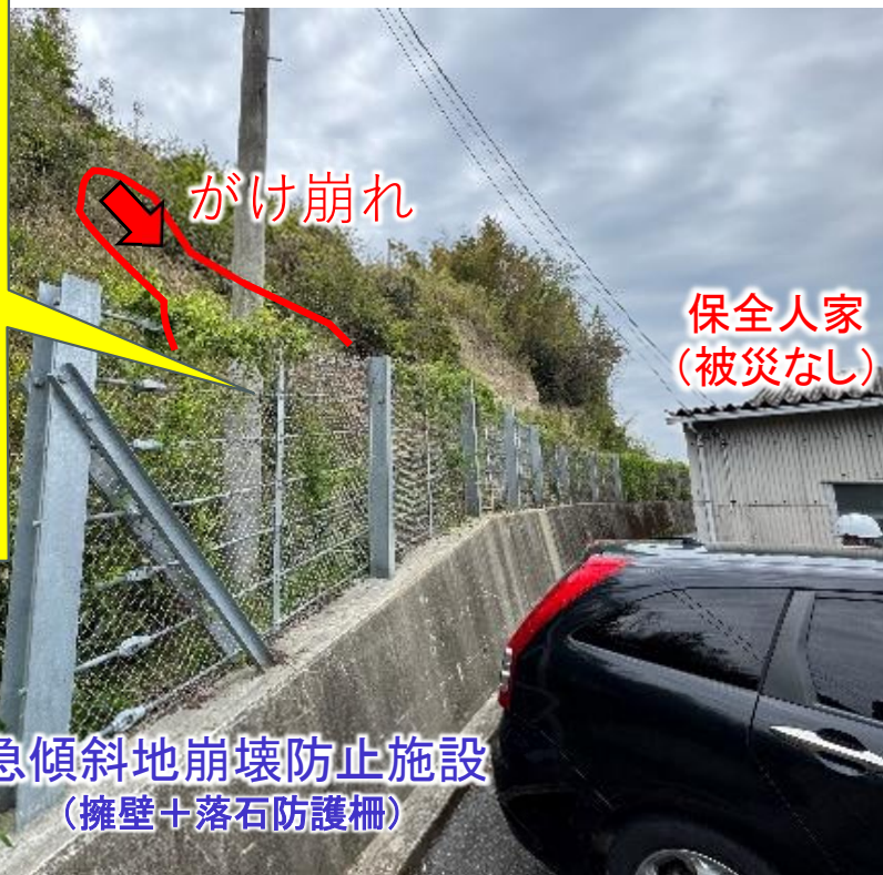
がけ崩れ発生状況・崩落土砂捕捉状況・・・4月13日撮影
