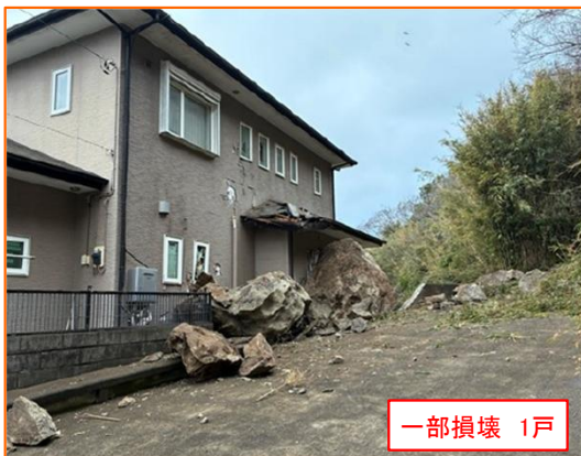
2/26 あわぐん きよなんまち りゆうしま 千葉県安房郡鋸南町竜島
