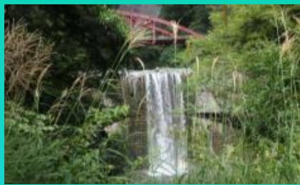
現地調査（芦安堰堤）
