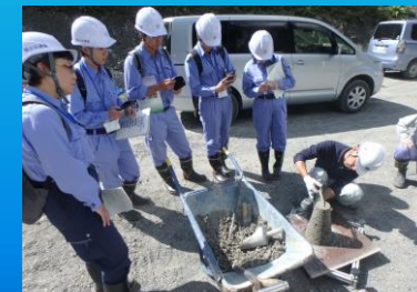
工事現場体験（スランプ試験体験）
