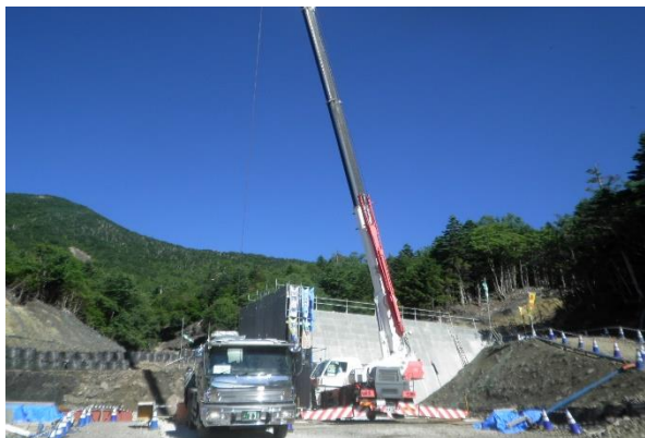
大真名子東沢砂防堰堤(施工中)
