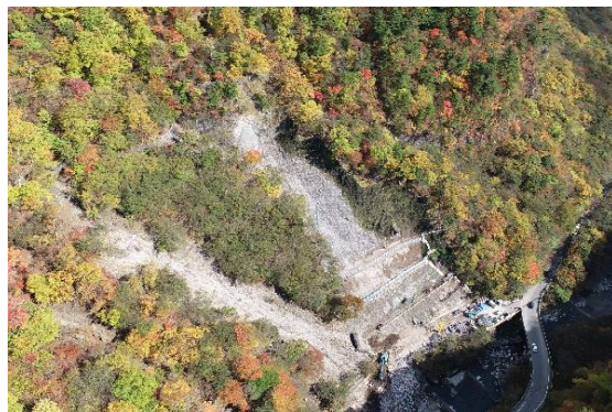
馬返山腹工(施工中)
