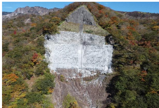
稲荷川上流山腹工(施工中)
