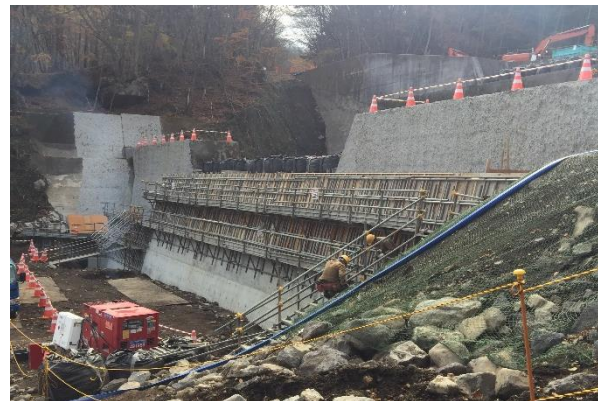
ワミ沢砂防堰堤改築(施工中)
