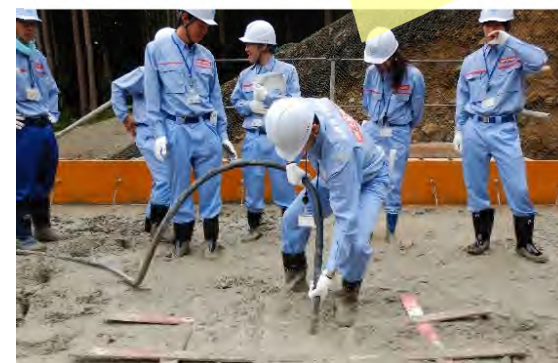
実務体験（コンクリート締固め）
