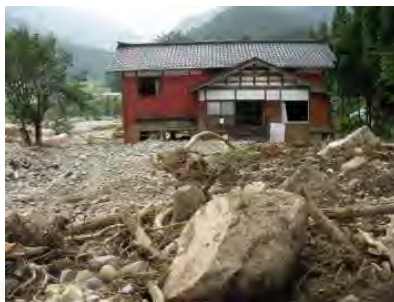
「平成23年7月新潟・福島豪雨」 による土砂災害と砂防設備の整備 状況（南魚沼市）
