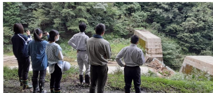
現地調査（台風後、砂防堰堤の土砂と流木の捕捉状況など）
