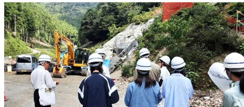
砂防堰堤工事の現場視察
