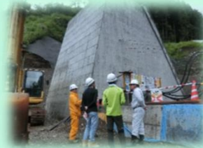
砂防堰堤の工事現場
