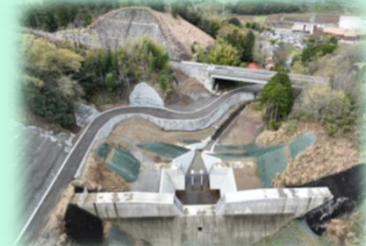
既設の砂防堰堤（地先砂防）
