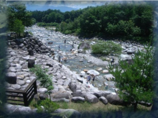
水辺空間の利用や景観を考慮した 太田切床固工群
