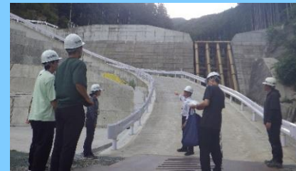
砂防堰堤工事現場見学
