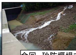
今回、砂防堰堤で 土砂を捕捉
