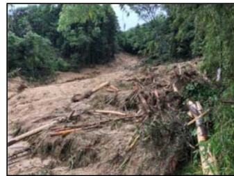
現地の被災状況
