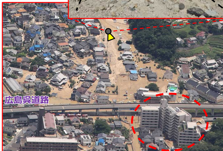
被災後写真 (国際航業株式会社 提供)
