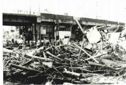
（中央区）ＪＲ高架北側の堆積土砂（S42災害）
