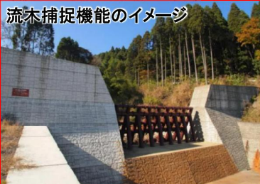
砂防堰堤(改築) 嵩上げ・流木捕捉機能追加
