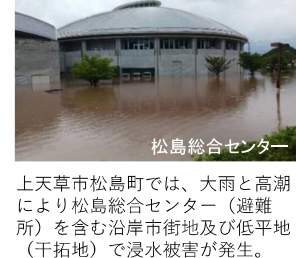
上天草市松島町では、大雨と高潮により松島総合センター(避難所)を含む沿岸市街地及び低平地(干拓地)で浸水被害が発生。
