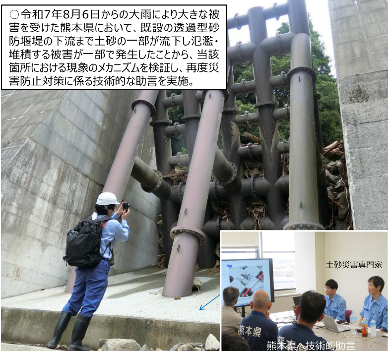
砂防堰堤による土砂捕捉状況(敷川内川)
