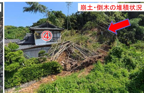
斜面の崩壊状況(頭部滑落崖)
