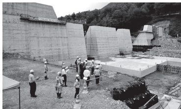
写真－1 砂防工事現場見学（帯広河川事務所）
