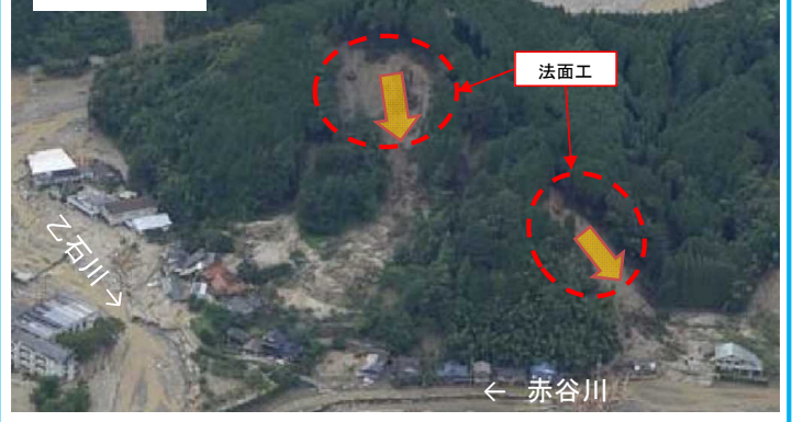
斜面崩壊状況
