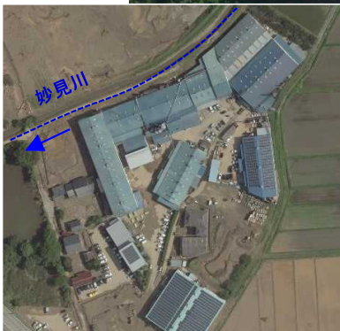
砂防堰堤下流の保全対象 (工場、人家 等)
