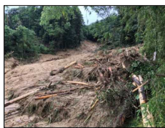
現地の被災状況
