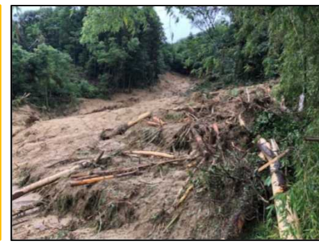
現地の被災状況
