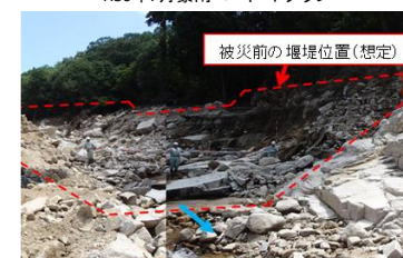
石積砂防堰堤の施設効果例(広島県安芸郡坂町 総頭川) 石積砂防堰堤の被災例(広島県安芸郡坂町 天地川)
