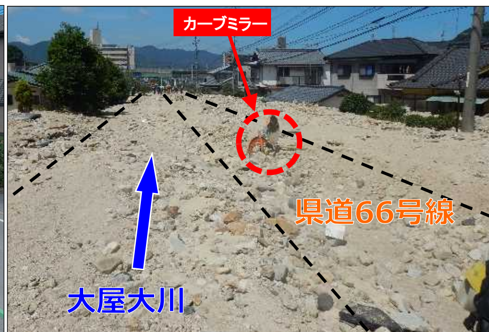
被災後状況写真
