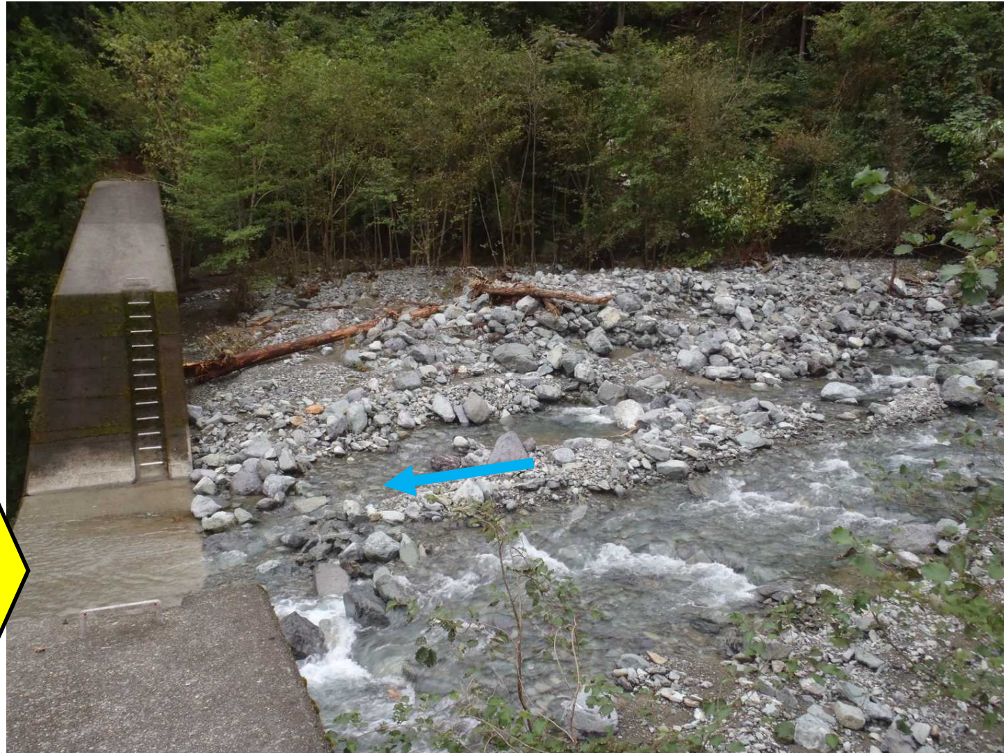
土石流発生後
