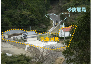
土石流対策施設 (新上五島町上五島地区 真浦川)
