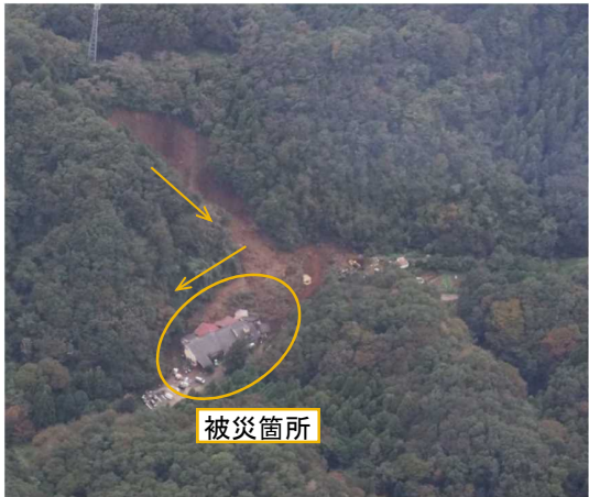
崩壊箇所全景
