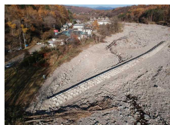
流路固定のためのブロック設置
