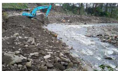
流路確保のための河道掘削状況
