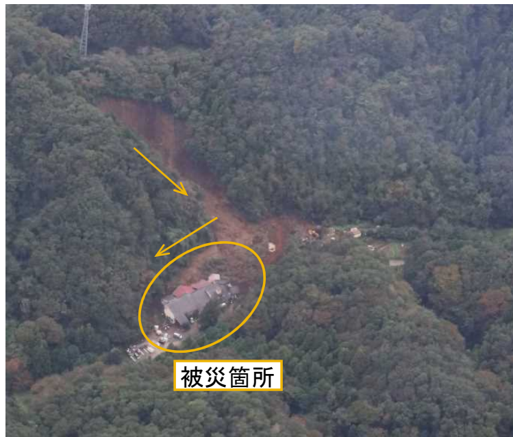
崩壊箇所全景
