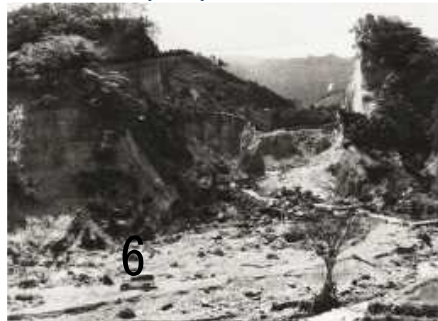
狩野川台風(S33)による被害(伊豆市)
