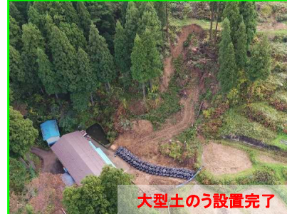
施設効果事例 待受式擁壁が土砂を捕捉
