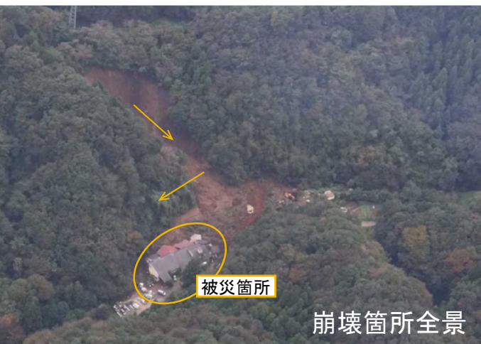
崩壊箇所全景
