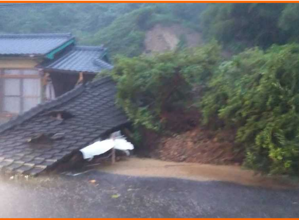
7/4 土砂崩れ いずみ ながしまちよう ひらお 鹿児島県出水郡長島町平尾地区
