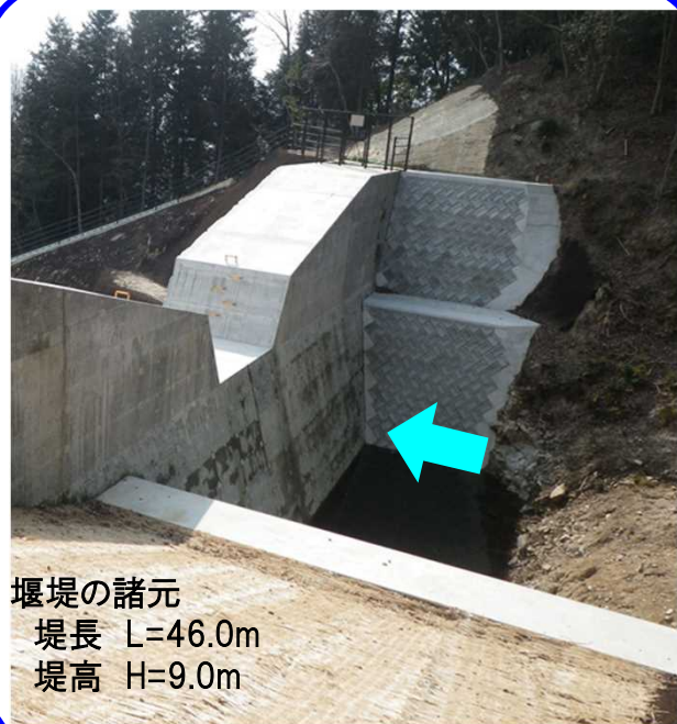
土石流発生前 (H29.3撮影)
