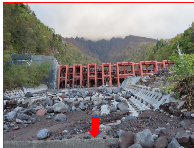
土石流発生後
