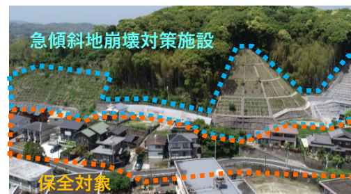
急傾斜地崩壊対策施設（佐世保市陣の内町）
