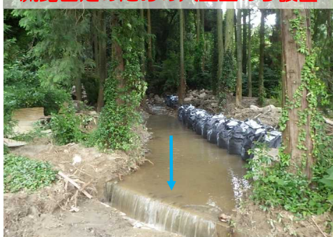
災関砂防の例(福岡県大牟田市)
