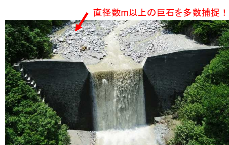
飯島第6砂防堰堤の捕捉状況
