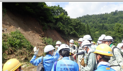
現地調査の様子
