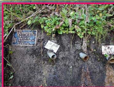
同地区内の既設横ボーリング工
