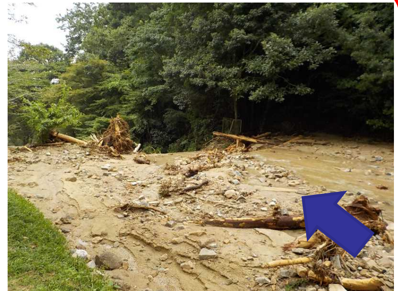
土石流発生直後 (R3.8.15)
