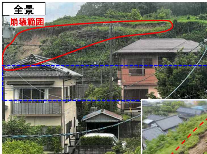
がけ崩れ発生状況
